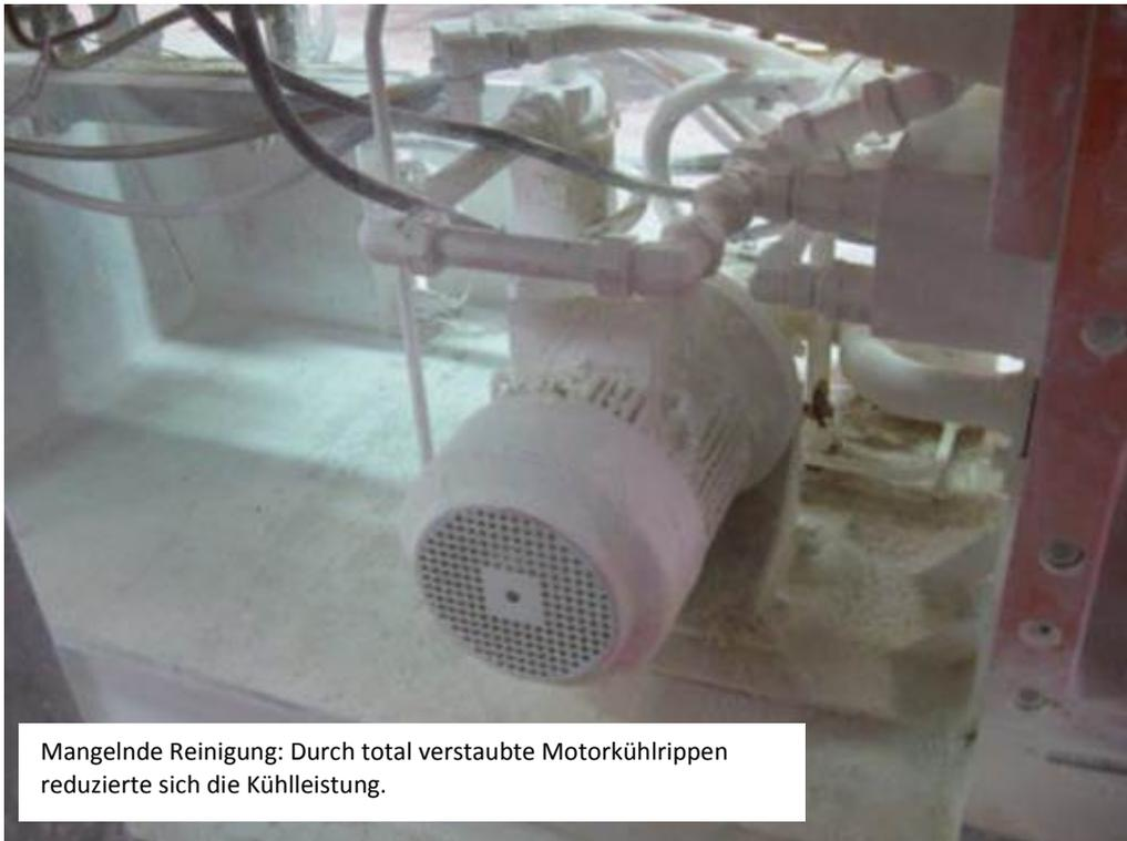
Mangelnde Reinigung: Durch total verstaubte Motorkühlrippen reduzierte sich die Kühlleistung.
